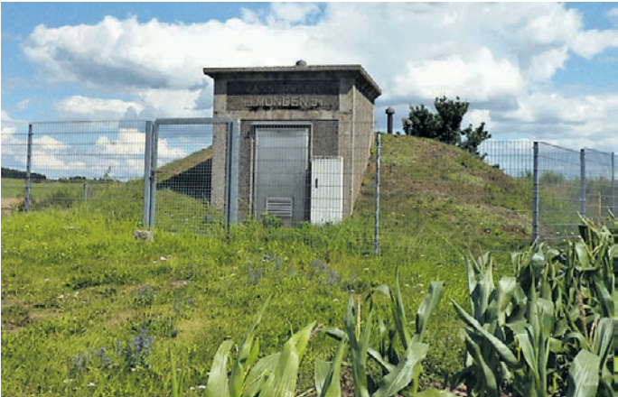
Der Hochbehälter Münden soll im kommenden Jahr durch einen Fertigbehälter ersetzt werden. Foto: Scheuermann
